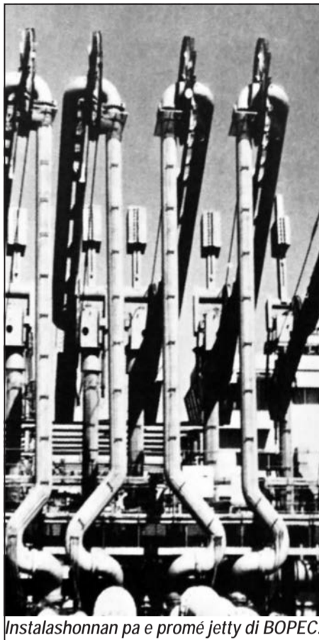
Instalashonnan pa e promé jetty di BOPEC.
